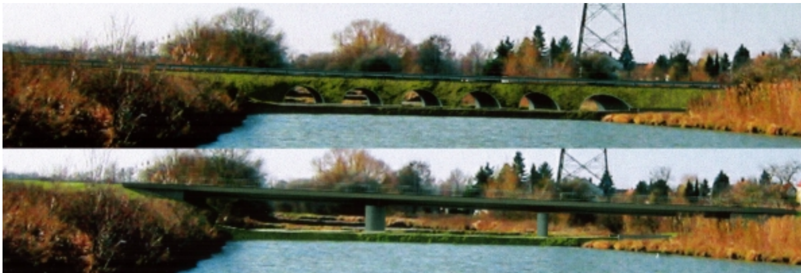
Oben die Durchlassgalerie, unten die Brückenvariante.
