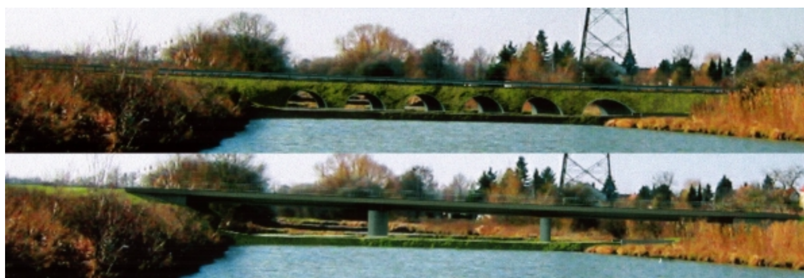
Oben die Durchlassgalerie, unten die Brückenvariante.
